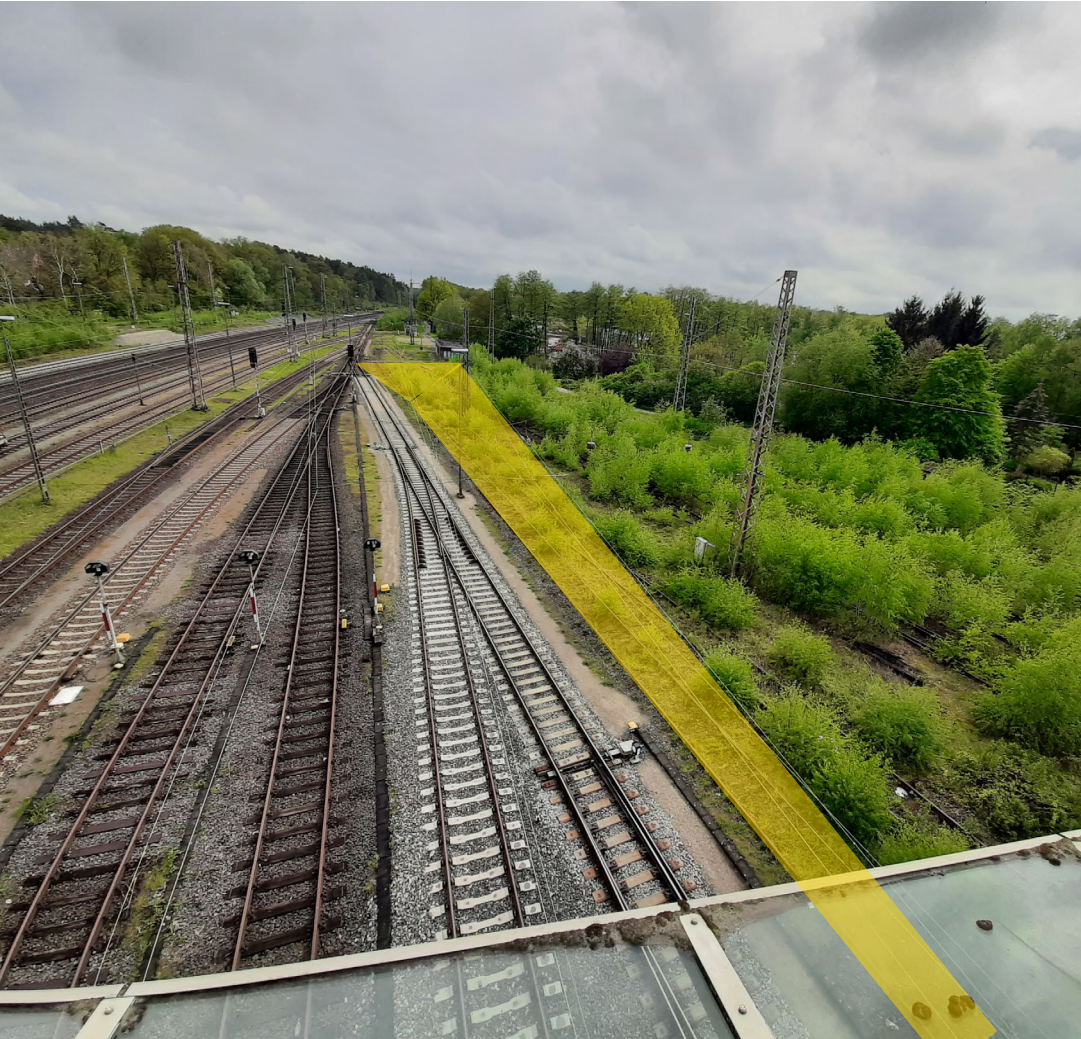
Strecke 1720 – km 130,3, Blickrichtung Süden
